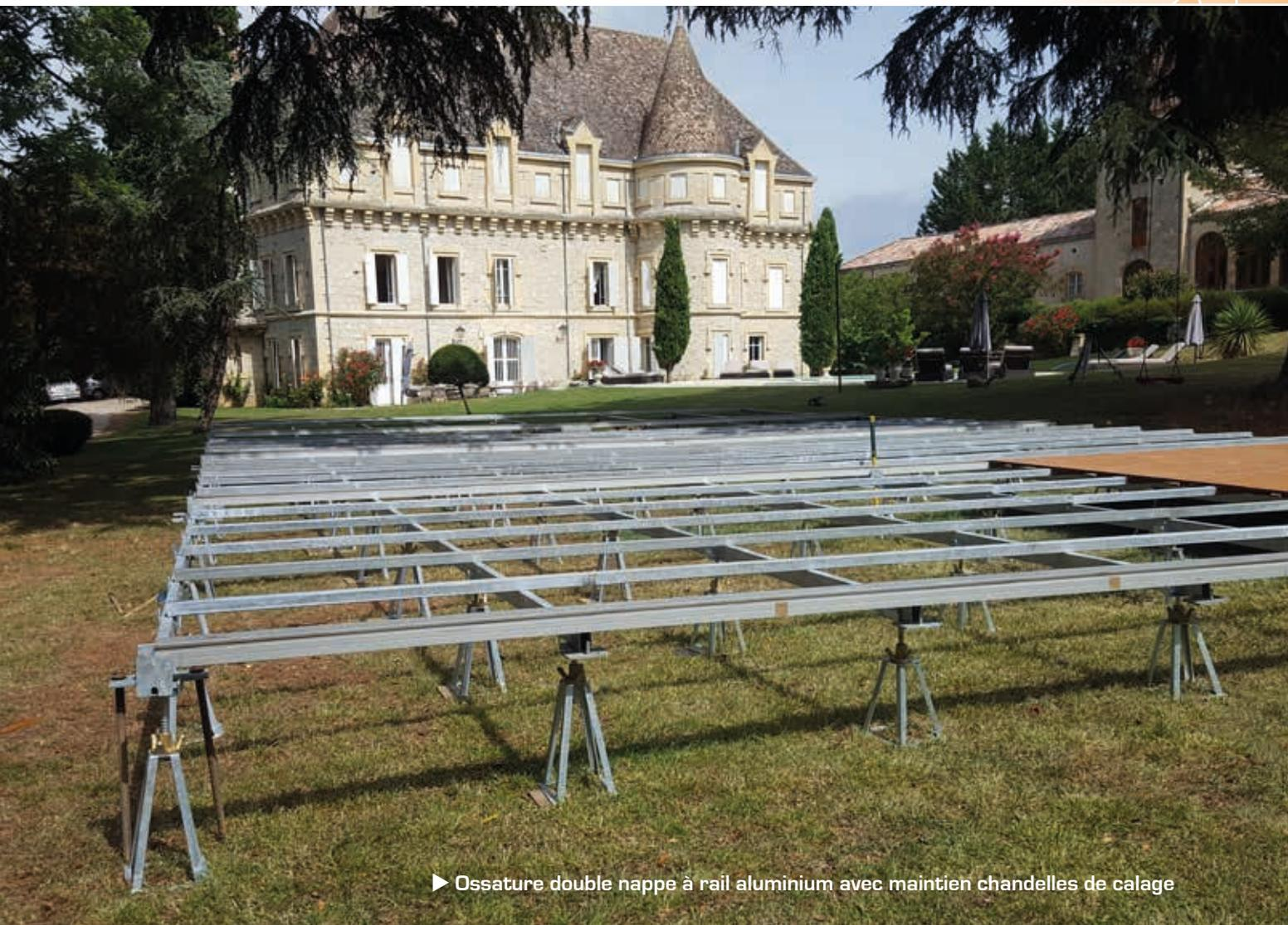
► Ossature double nappe à rail aluminium avec maintien chandelles de calage
