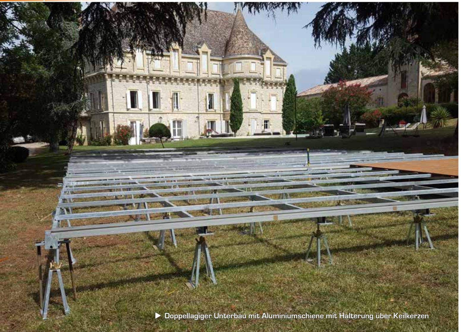
► Doppellagiger Unterbau mit Aluminiumschiene mit Halterung über Keilkerzen
